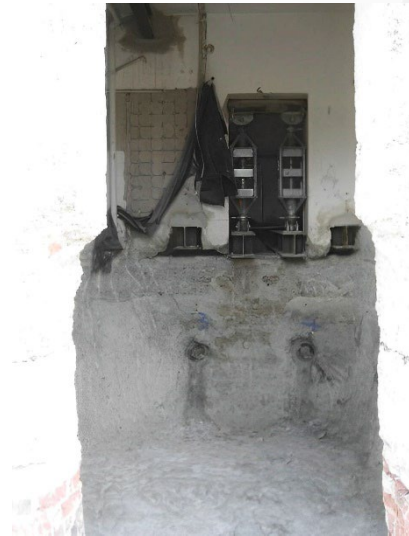
Deckenverstärkung mit CFK-Lamellen und Gebäudeunterfangung mit rückverankerten HDI-Körpern
