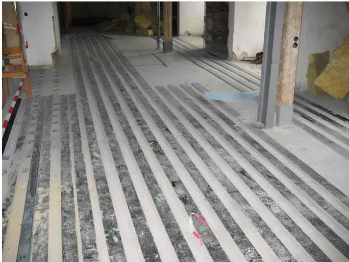
Deckenverstärkung mit CFK-Lamellen und Gebäudeunterfangung mit rückverankerten HDI-Körpern
